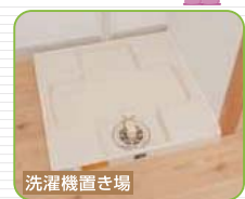
洗濯機置き場 家事動線を考慮し、使い勝手の良い場所に新設。
