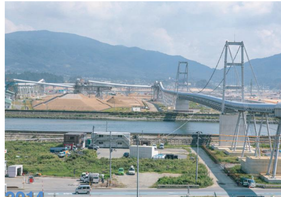
2014年7月 かさ上げに必要な土を運んだベルトコンベヤー。現在は役目を終え、撤去されている。 ©青木 登
