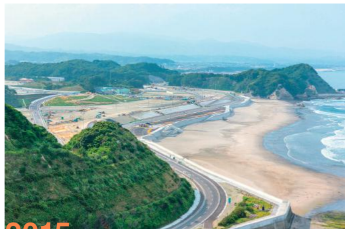
2015年2月 宅地造成工事が進む豊間と薄磯地区。 ©佐藤慎吾
