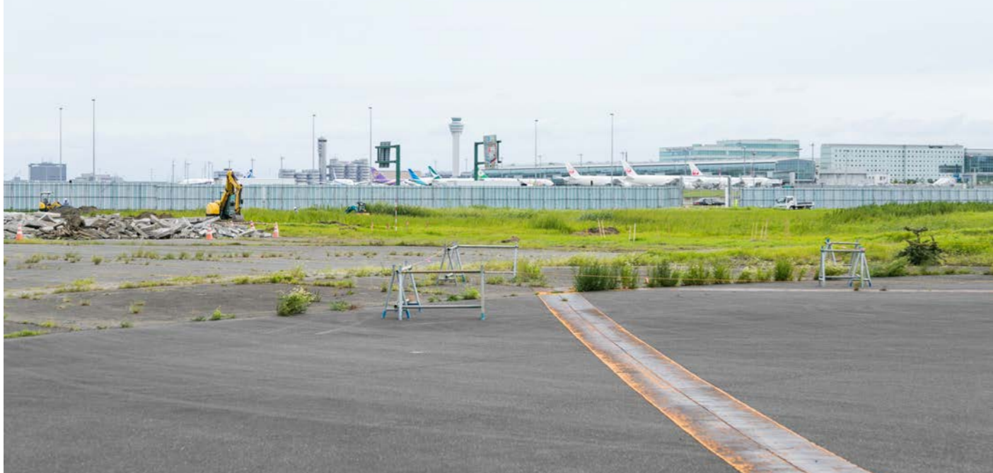
ここが、現在URが面整備を進めている空港跡地第1ゾーン。奥には国際線ターミナルに駐機している飛行機が見える。
