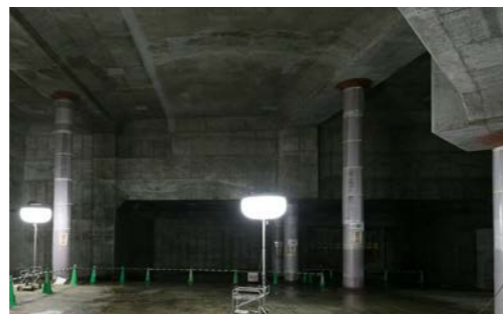
工事が進む東口地下広場。
