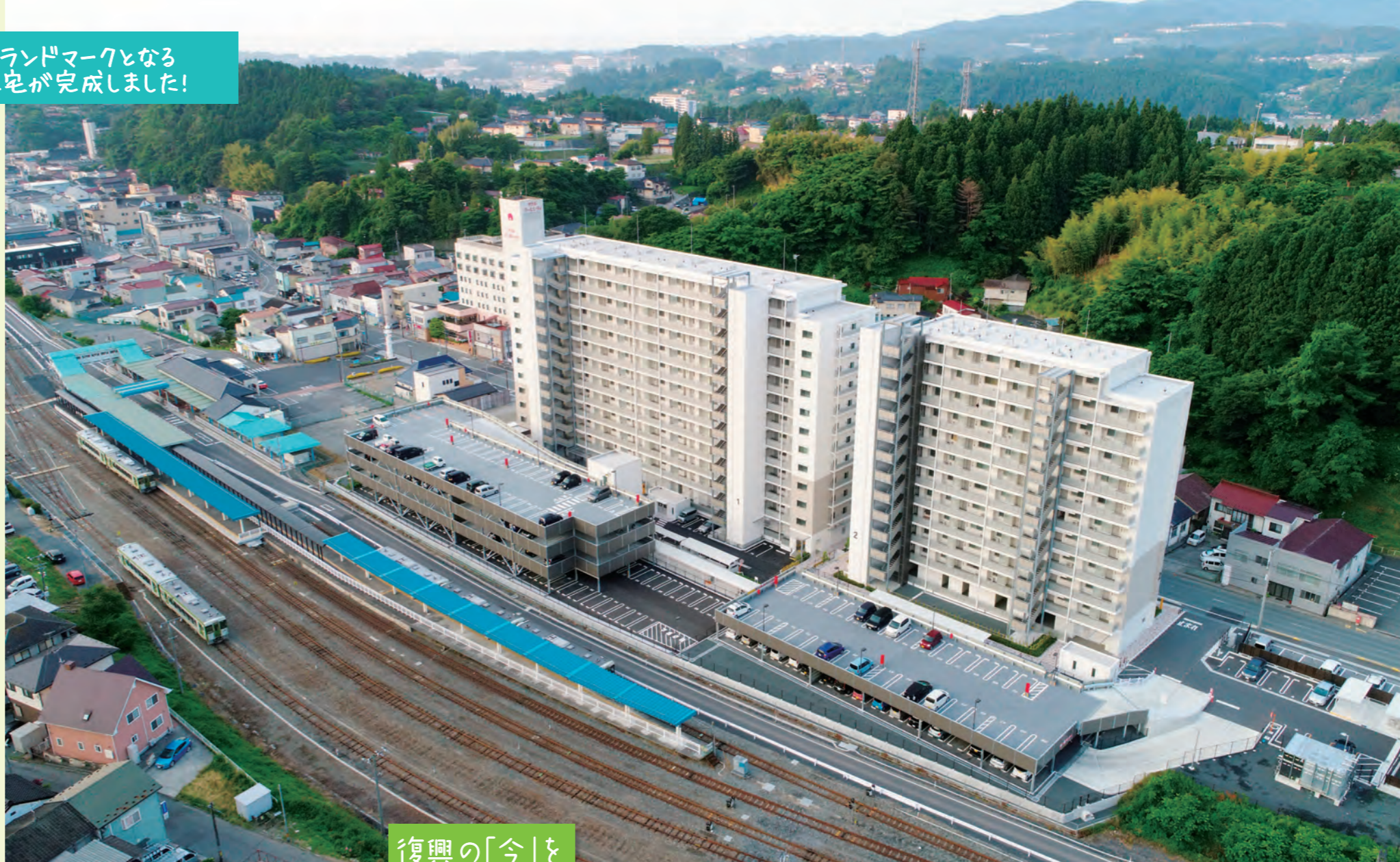
気仙沼駅前という交通利便性、生活利便性の高い地に立つ気仙沼駅前住宅。右の12階建ての2号棟(64戸)は2016年10月に先行して引き渡し、13階建ての1号棟(130戸)が2017年5月30日に引き渡された。
