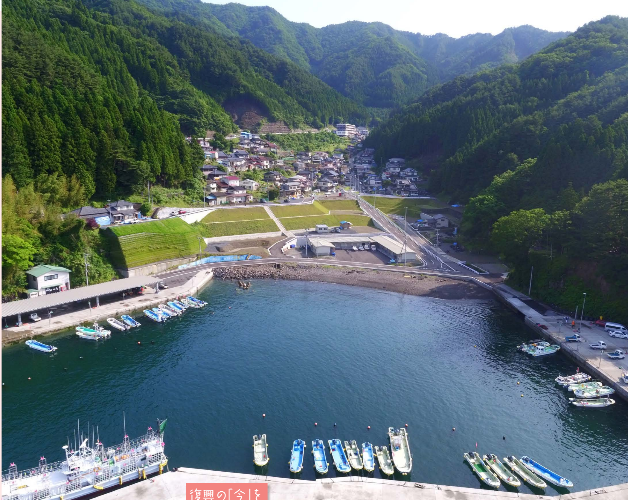
唐丹湾の海側上空から眺める花露辺地区。奥の山間に見える4階建ての建物が災害公営住宅だ。
