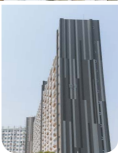
外壁に露出していた室外機置き場をアルミ製の「木の葉パネル」で覆い(上)、外壁もリニューアル(右)。
