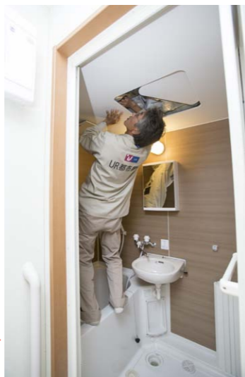
浴室の天井換気扇のダクト接続や天井裏の断熱材の状況、配線の保護などまで細かくチェックする姿に無駄な動きはなく、緊張感が漂っている。
