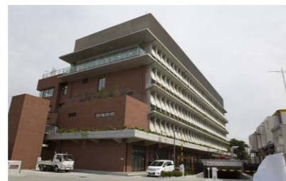
上/地上5階地下2階建ての「元気創造プラザ」。この建物と地下の総合スポーツセンターは省エネルギーにも配慮しており、隣接地にあるごみ処理施設で発生する熱エネルギーで発電した電力を供給。ビルエネルギー管理システム(BEMS)を導入して、空調や照明などを効率的に運用する。右/各フロアの壁に、平常時と災害時それぞれの機能を表示して市民への徹底を図る。
