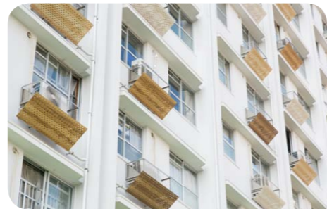
外壁に露出していた室外機置き場をアルミ製の「木の葉パネル」で覆い(上)、外壁もリニューアル(右)。
