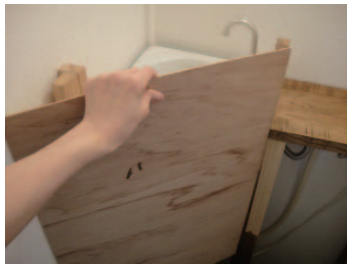
支柱を立てればタンクカバーや棚だって作れます。タンクや水道管の高さに合わせて角材をカットして土台を作り、そこにカバー用のベニヤ板をはめ込みました。
