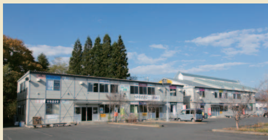
宿泊施設を含む総合リゾート「グリーンピア三陸みやこ」の敷地内に立つたたろちゃんハウス。2階建ての3棟からなる。 ●岩手県宮古市田老向新田148
