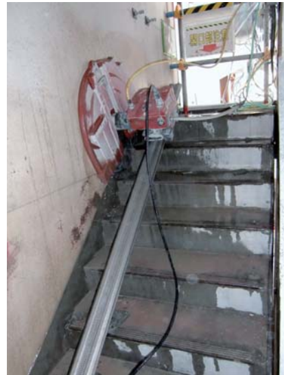
ウォールソーによる既存階段の切断
