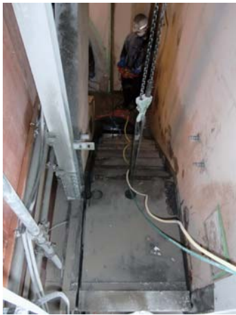
切断後の吊り下ろし
