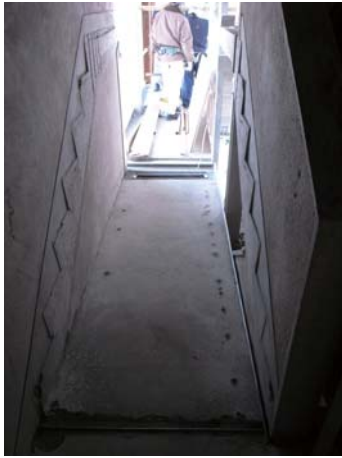
切断面の状況
