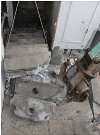
ニブラーによる解体材の分割
