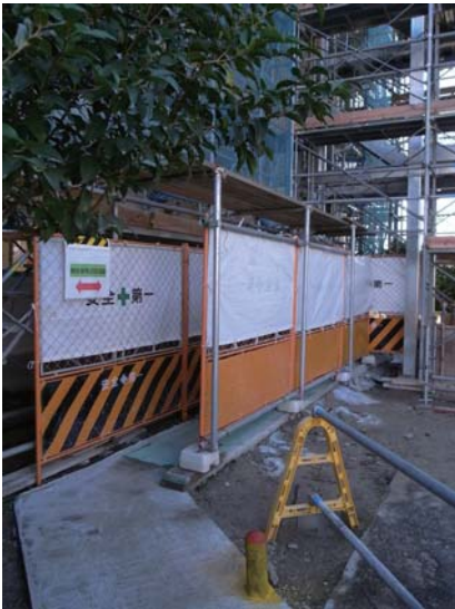
居住者通路(増築工事中)
