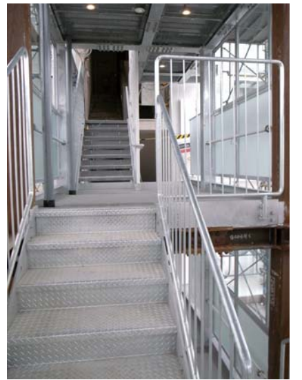
仮設階段より階段室を見る
