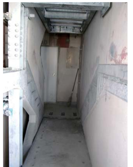
通路設置後の状況
