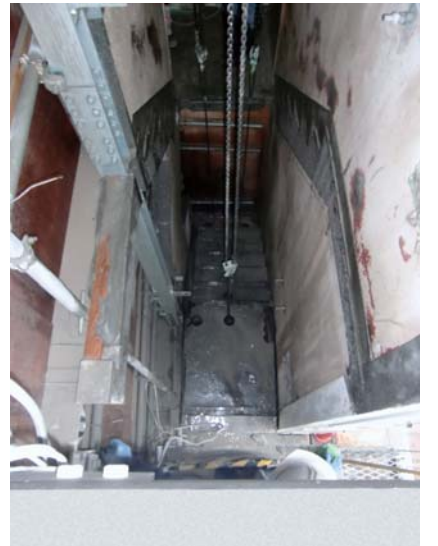
切断した階段の吊り下ろし
