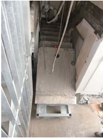
解体材の引き出し
