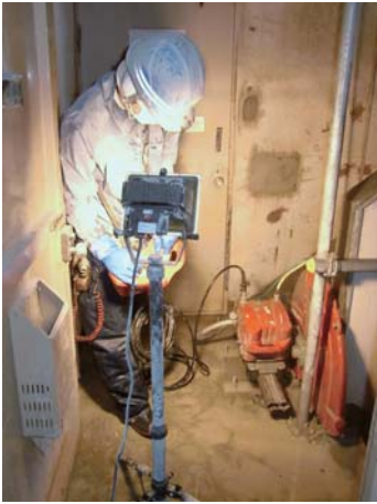
階段端部の切断
