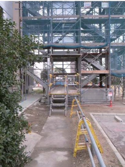
居住者通路(通路工事中)
