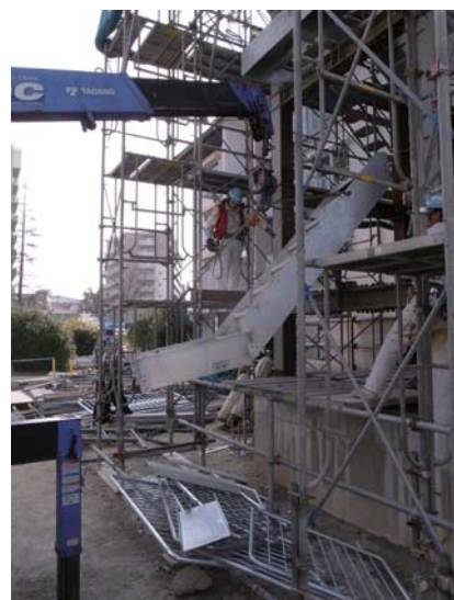
仮設階段撤去
