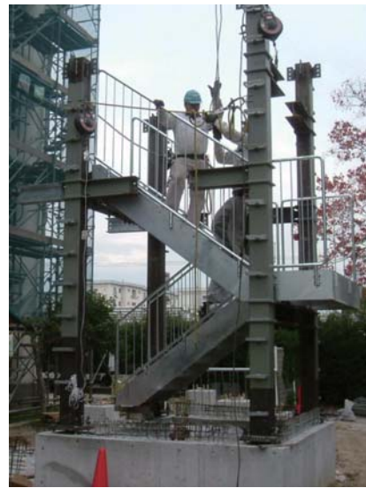
鉄骨躯体建方
