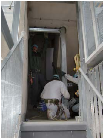
間柱・受梁設置
