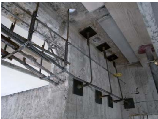
既存梁側面補強
