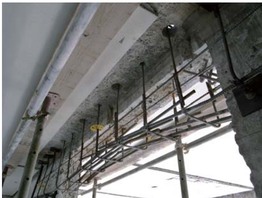
梁中央部配筋
