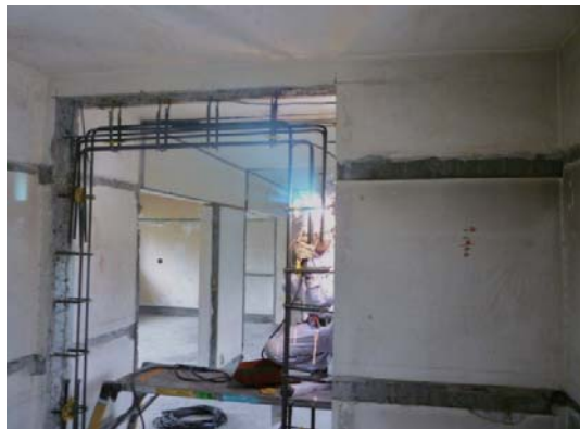
フレア溶接施工状況
