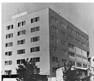
1965年当時の中広島変電所 (1965年完成)
