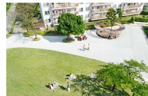
外観・屋外空間リノベーション ようこうだい 洋光台団地（神奈川県）「団地の未来」プロジェクト
