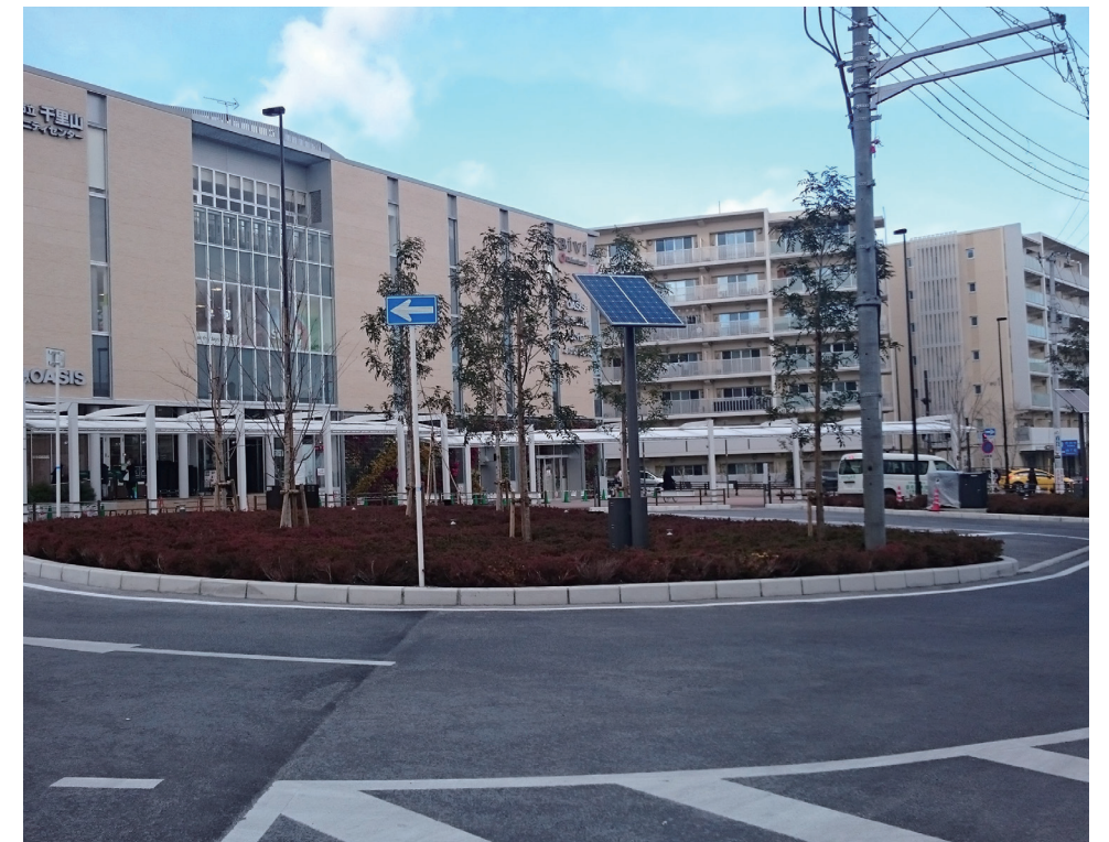
整備後の阪急千里山駅 駅前広場
