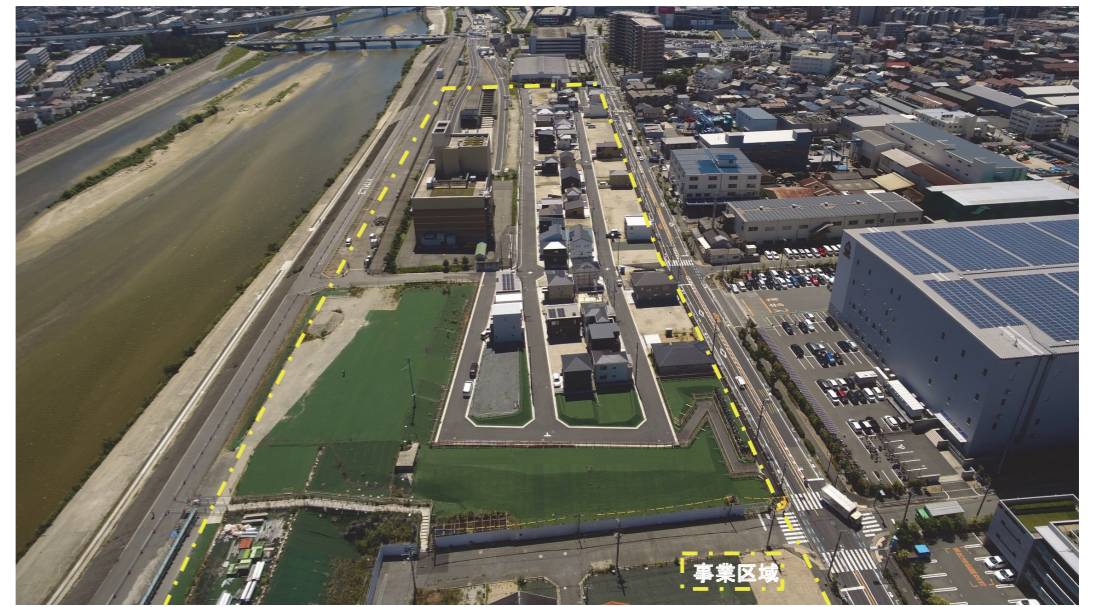
大和川左岸(三宝)地区整備状況(2022年6月現在)
