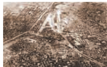
■押上・業平橋付近の航空写真(大正11年)
