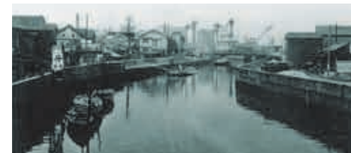
■北十間川から生コンクリート工場を望む(昭和30年代)
