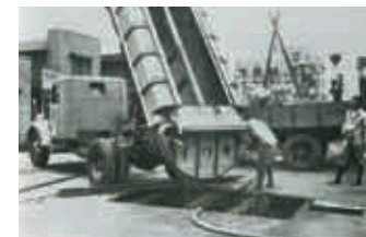
生コン輸送用アジテータ ダンプカー(昭和26年)
