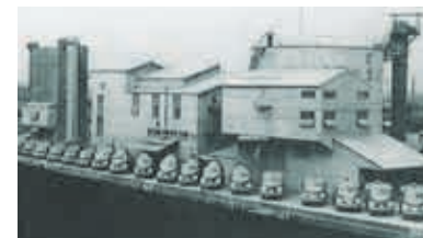
磐城コンクリート工業(株) 業平橋工場(昭和26年)
