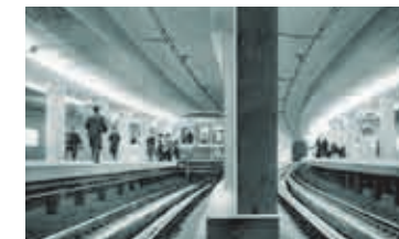
日本初 地下鉄との相互乗り入れを開始した押上駅(昭和38年)
