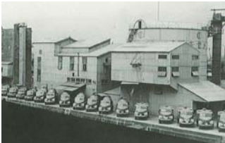
磐城コンクリート工業(株)業平橋工場 [1951(昭和26)年]
