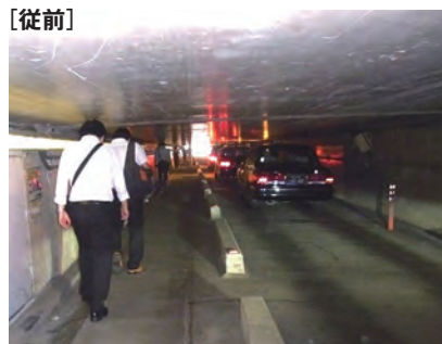
高輪橋架道橋(通称:お化けトンネル)
