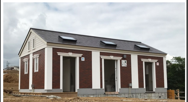
防災公園内トイレ
