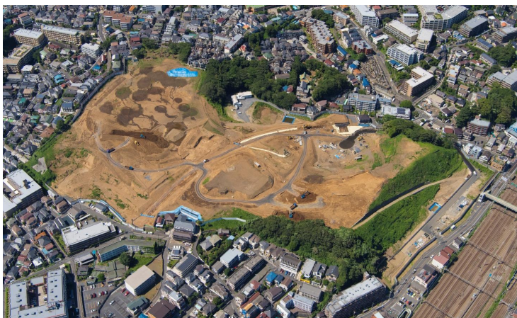
工事区域全体
