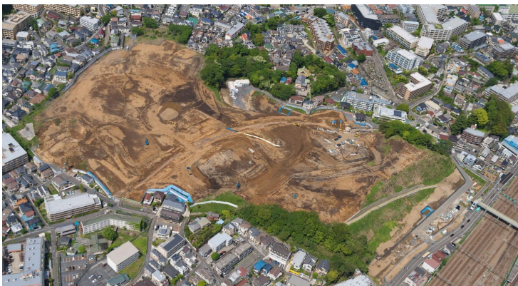
工事区域全体
