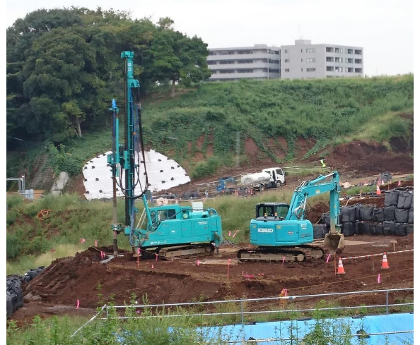
今月の擁壁基礎工事状況
