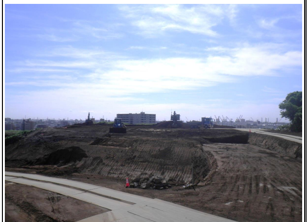
土工事状況(切土部)
