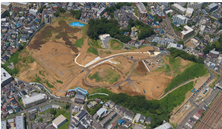
工事区域全体
