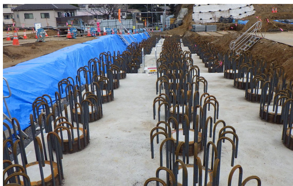
擁壁基礎杭頭部の様子
