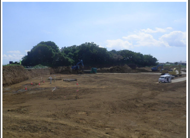
土工事状況（切土部）
