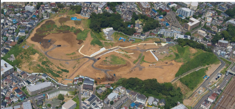
工事区域全体
