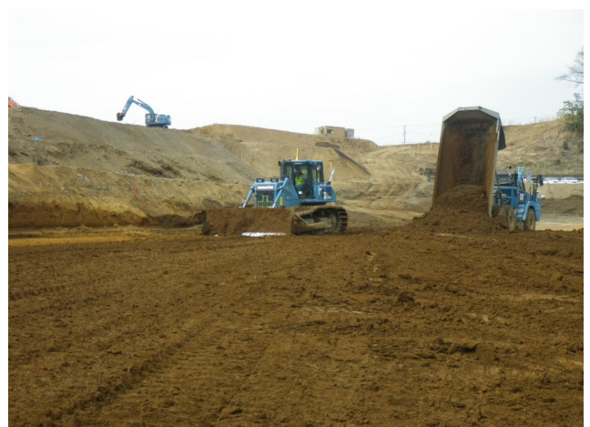
盛土敷均し転圧状況
