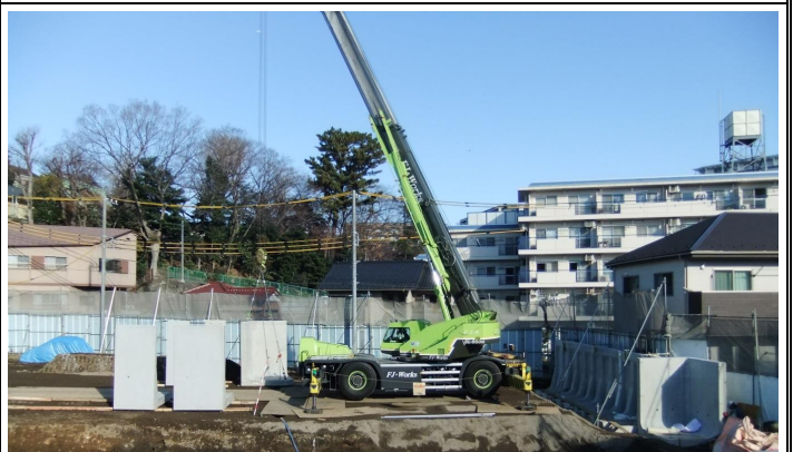
12月の場内工事状況
