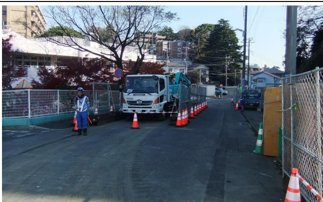
12月の下水工事状況
