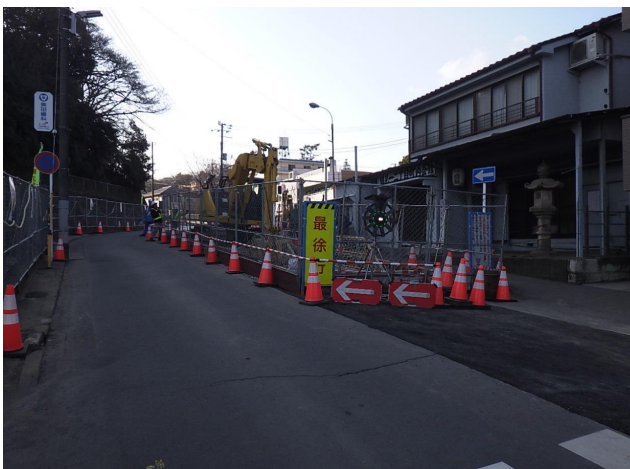
下水道工事状況
