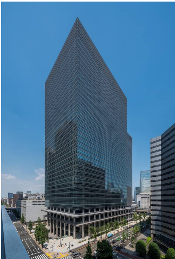
▲ウエストタワー外観（平成30年8月撮影）
