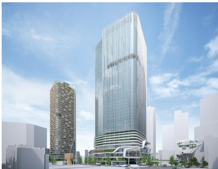
青山通りから渋谷方面を望む（右から A 街区、B 街区、C 街区）
