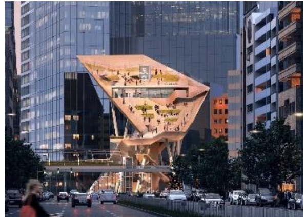
青山通りから見たA街区
