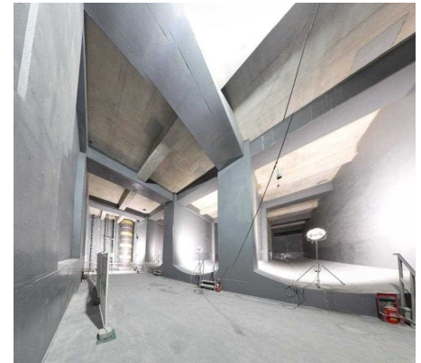
▲雨水貯留施設の内部
