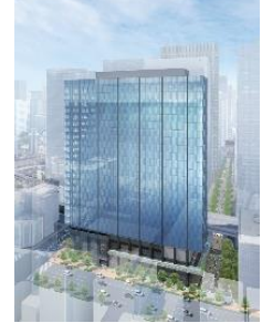
▲大手町ゲートビルディング外観
