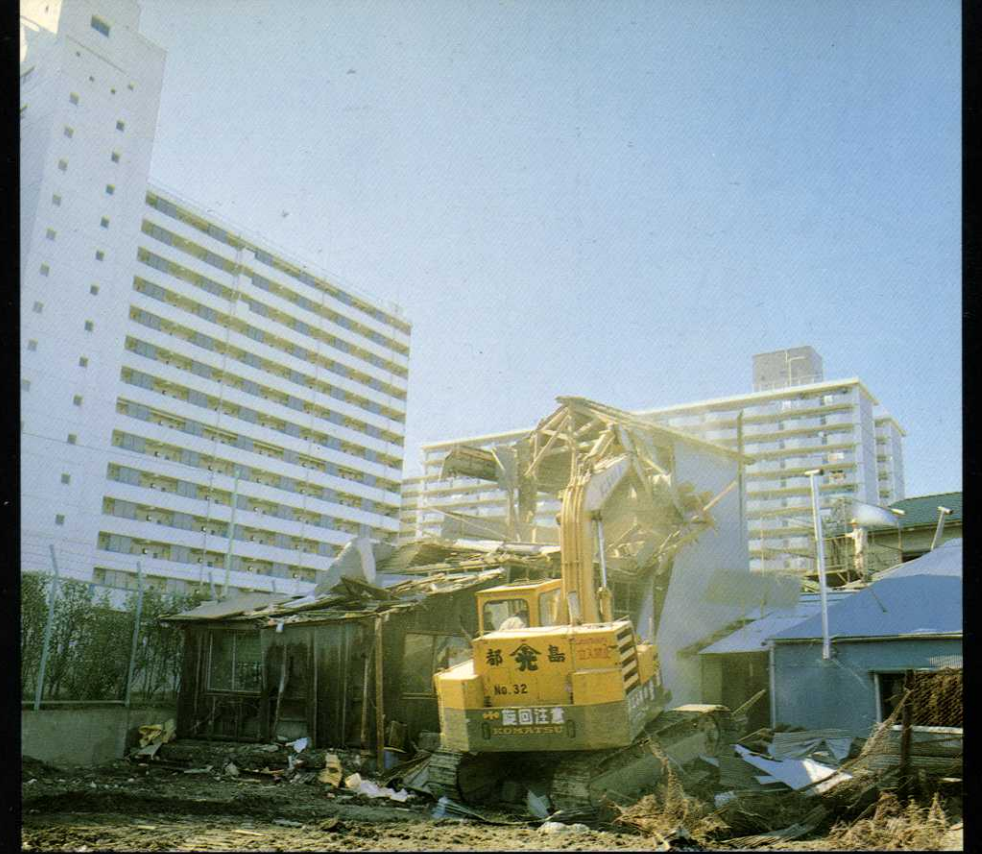
除却工事中 (55・1)
