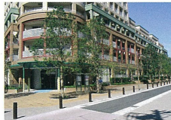
オーバルコート大崎ビュープラザ(エントランス)
