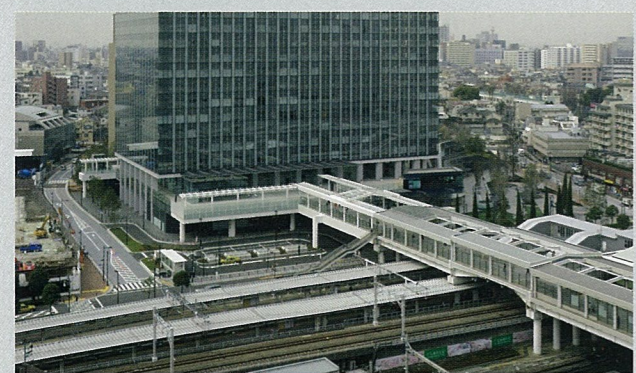
地区幹線4号道路 (District trunk line No.4) 延長約150m、幅員約12~15mを整備。 同時に電線共同溝を整備。 (平成17年度完成)
