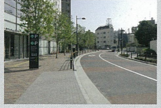
地区幹線4号道路 (District trunk line No.4) 延長約150m、幅員約12~15mを整備。 同時に電線共同溝を整備。 (平成17年度完成)
