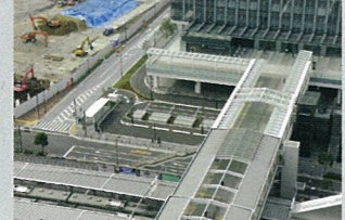
歩行者デッキと交通広場 (Pedestrian deck and Station square) 大崎西口E東地区開発事業と連携した基盤整備。
