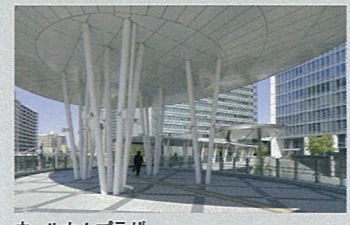
ウェルカムプラザ (Welcome Plaza) アートヴィレッジ大崎と大崎駅及び環状6号線(山手通り)をつなぐ自由通路。(平成18年度完成)
