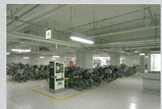
大崎駅西口地下駐輪場 (Bicycle-parking lot) 大崎駅西口駅前交通広場地下に、943台が利用できる地下駐輪場を整備。(平成19年度完成)
