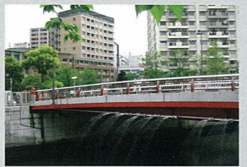
御成橋 (Onari Bridge) 再開発地区(オーバルコート大崎等)の区道拡幅と連携し、御成橋を整備。下水再生放水施設を併設。(平成16年度完成)
