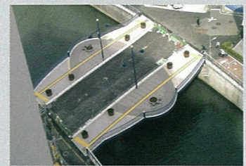
山本橋 (Yamamoto Bridge) 東五反田二丁目第2地区再開発事業と連携し、地区幹線道路整備に伴い目黒川既設山本橋を拡幅整備。(平成17年度完成)
