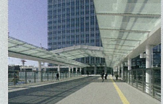
大崎駅西口歩行者デッキ (Pedestrian deck) 西口の開発に併せ、大崎駅東西自由通路(夢さん橋)幅員約15mを延伸整備。 (平成19年度完成) 将来、西口各地区の開発事業地間を接続する予定。
