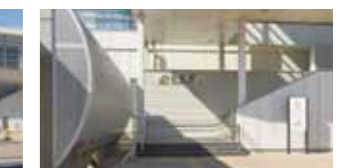
●勝田駅舎東口階段の改修
