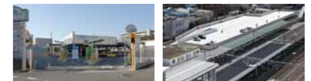
●市営勝田駅東口南駐車場(1階) ●市営勝田駅東口南駐車場(2階)
