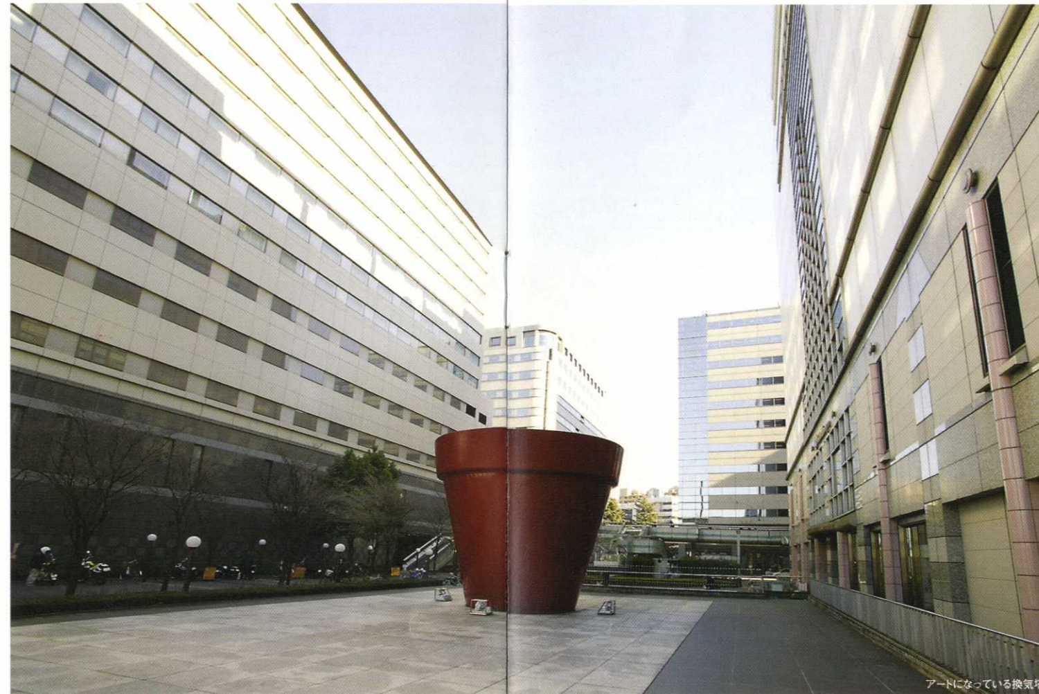
アートになっている換気塔
