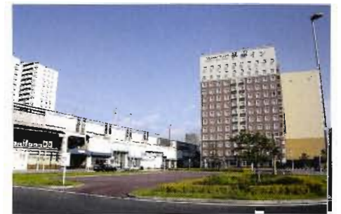
ホテルも開業している 千葉みなと駅前広場
