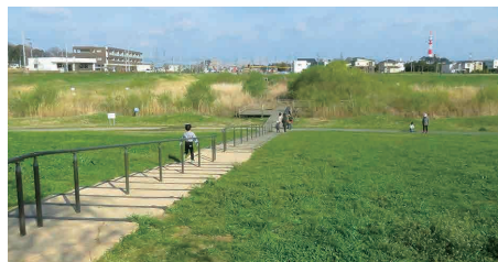
大堀川水辺公園と防災調節池
