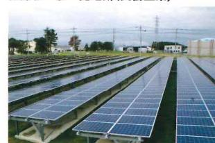
再生エネルギー特別措置法(H23.8制定)に基づき設置された国内初のメガソーラー発電所。平成28年6月時点で、太陽光パネル8,246枚、年間発電量179万キロワットに上り、発電された電力は地域に供給されている。
