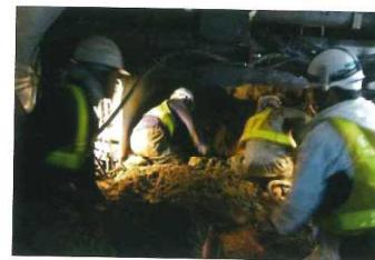
ボックスカルバート内は人力で掘削し、ベルトコンベアで排土している。
