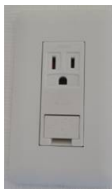
専用回路ではないエアコン用コンセント (15A 100V)
