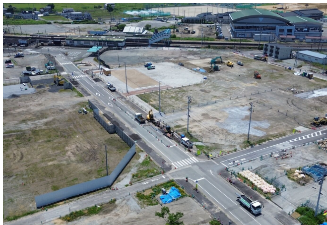
浪江駅周辺ドローン撮影 (令和8年6月29日撮影)
