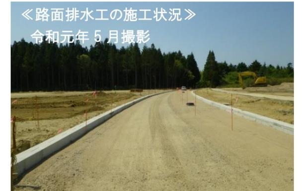
平成 30 年 4 月の本格着工以降、基盤整備工事においては、整地・排水・道路の各工種工事が順調に進められております。現在の主な工事は、道路側溝（路面排水工）の設置を行っております。今年の夏ごろから順次舗装工事に着手する予定です。基盤整備工事全体は、今年度末の完成をめざして引き続き頑張ります。
