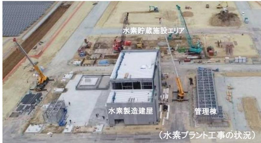
この水素貯蔵施設は、水電解装置から供給される水素を圧縮、輸送用高圧容器に充填して一旦貯蔵し、需要に応じて供給先へ出荷する施設です。
