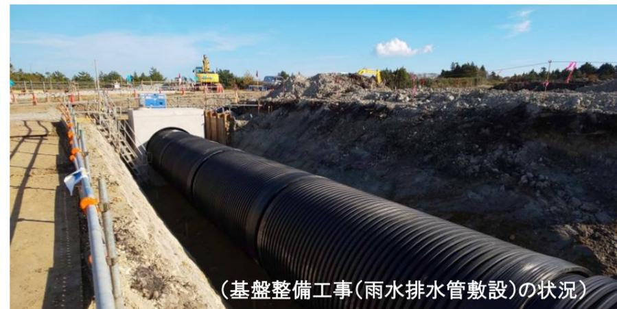
(基盤整備工事(雨水排水管敷設)の状況)
