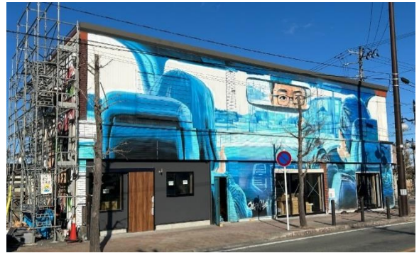
現在の様子（工事中）
