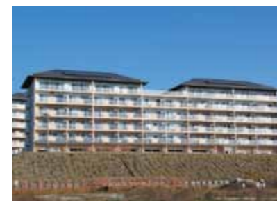
盛土の上に建設した災害公営住宅「下和野団地」。
