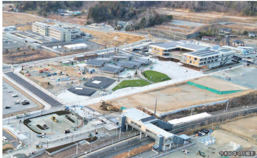
大野駅西交流エリア（産業交流施設「CREVAおおくま」と商業施設「クマSUNテラス」を望む）
