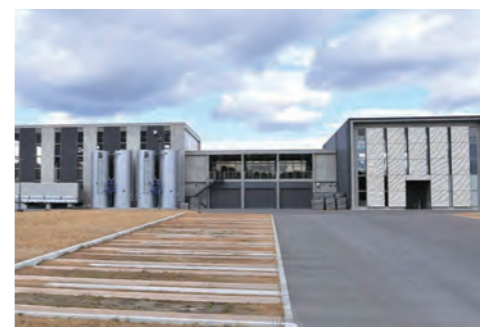
会澤高圧コンクリート 福島RDMセンター
