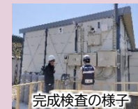
完成検査の様子
