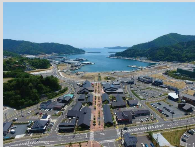
女川駅前レンガみち周辺地区（提供：女川町）
