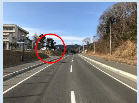
整備された都市計画道路 （赤丸部分が桜のあった場所）
