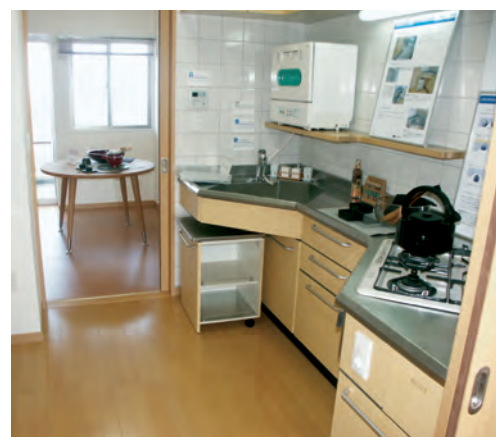
手すり一体型カウンター 機能が目立たないデザイン
