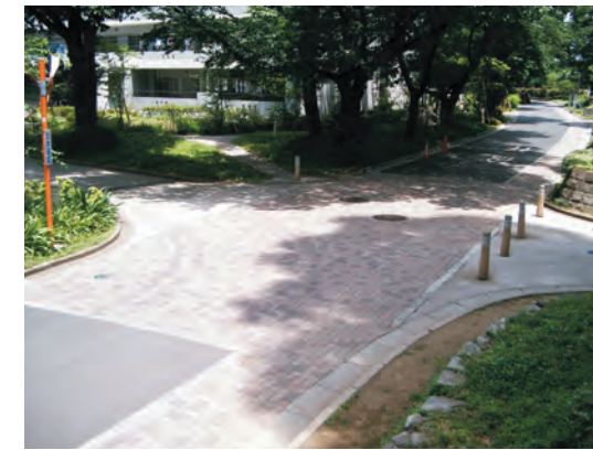
交差点部分を歩道と同様のテクスチャーとし、ドライバーに注意を促している。 武蔵野緑町パークタウン
