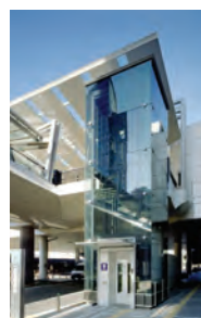
エレベーター全景
