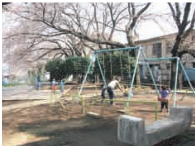
1958年に建設された東鳩ヶ谷団地
