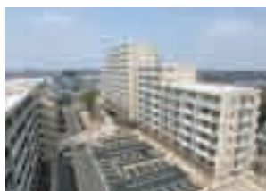
建替後のコンフォール東鳩ヶ谷団地
