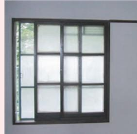
既存スチールサッシの内側に木製建具を設置し、断熱性をUP
