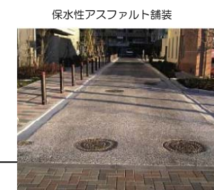
保水性アスファルト舗装
