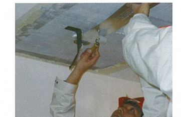
テープケーブル施工状況
