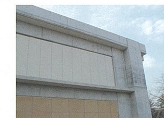
乾式外周壁工法の一例
