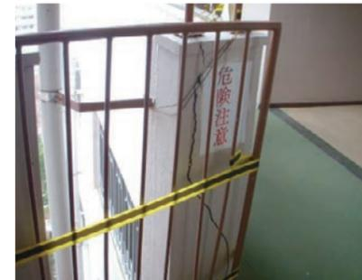
エキスパンションジョイント部の手摺壁の損傷(東京都のUR賃貸住宅)
