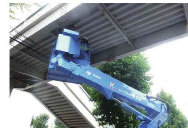
高所作業車による桁下の計画点検の状況(芝山団地)
