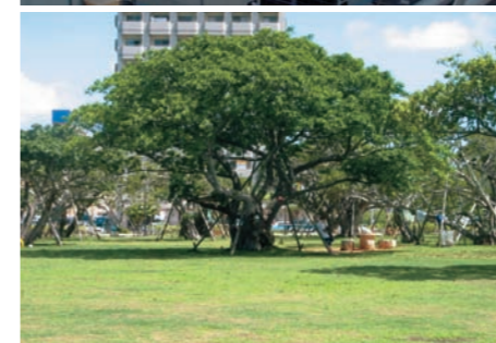
上) 業務ビル屋上に設置された蓄熱方式空調システム 下) 公園内に移植された既存樹木
