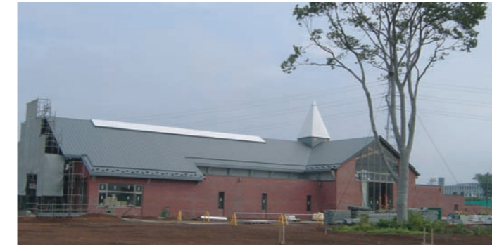
写真上)保存緑地での環境学習。地元の小学生達が自然に触れ、学ぶ場となっている。 写真左)船橋日大前駅(東葉高速鉄道)東口駅舎。素材はレンガ・木材等を利用。駅前広場の植栽には現況樹木を移植。駅前広場の舗装には焼却灰再生ブロックを使用。
