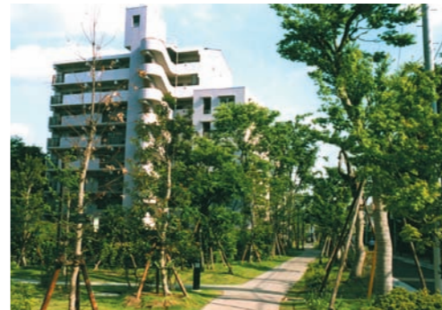
建替前の樹木を残した緑豊かな屋外空間
