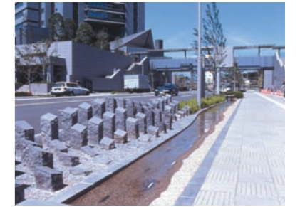
雨水調整池の貯留水を利用したせせらぎ(せせらぎ通り)
