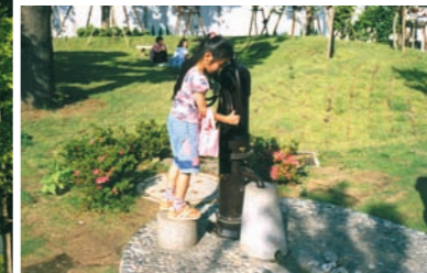
地下に貯留された雨水の利用
