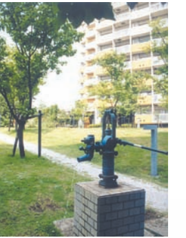
地下の貯留槽に蓄えた雨水を 手押しポンプで汲み上げて 散水に利用
