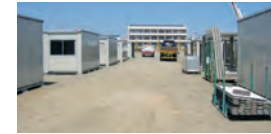
いわきニュータウンに建設された 応急仮設住宅
