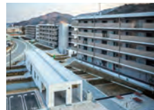
宮城県 牡鹿郡 女川町 町営大原住宅
