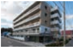
御社地町営住宅 (岩手県上閉伊郡大槌町)
