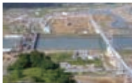
大量土の搬出のため設置された ベルトコンベア〔平成27年 9月作業完了〕 (岩手県陸前高田市)
