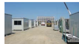
いわきニュータウンに建設された 応急仮設住宅
