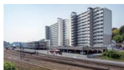
宮城県気仙沼市 市営気仙沼駅前住宅
